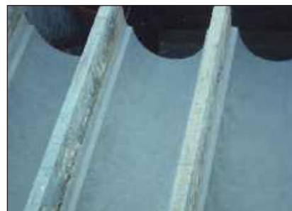
Alle drei Pumpenwannen werden mit ARC 791 beschichtet
