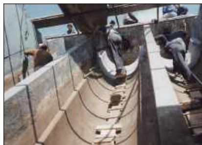
ARC 791 wird auf ordnungsgemäß vorbereitete Oberflächen aufgetragen
