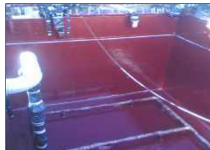
Auftragung der ARC CS4-Deckschicht
